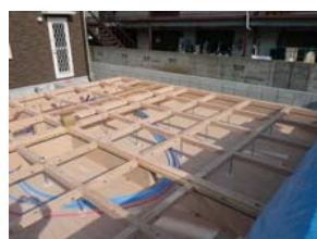
椽盤の目の土台
