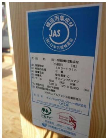
4寸（12cm角）の柱標準です。びくともしない二階の床
